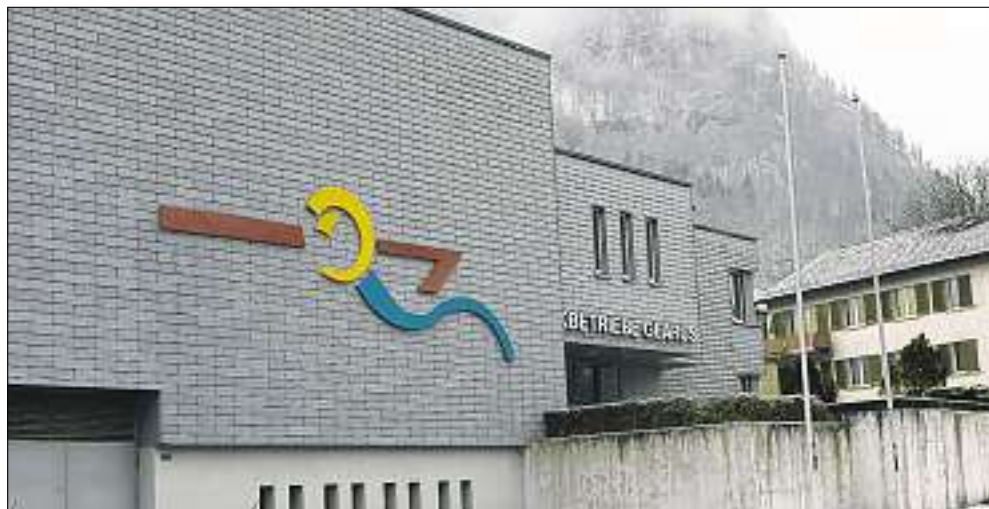
Der Sitz der Technischen Betriebe an der Feldstrasse in Glarus.
